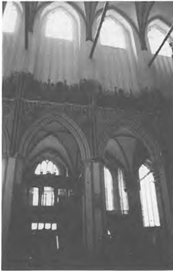
Abb. 2 Blick auf die südliche Mittelschiffwand der Stralsunder Nikolai-kirche
