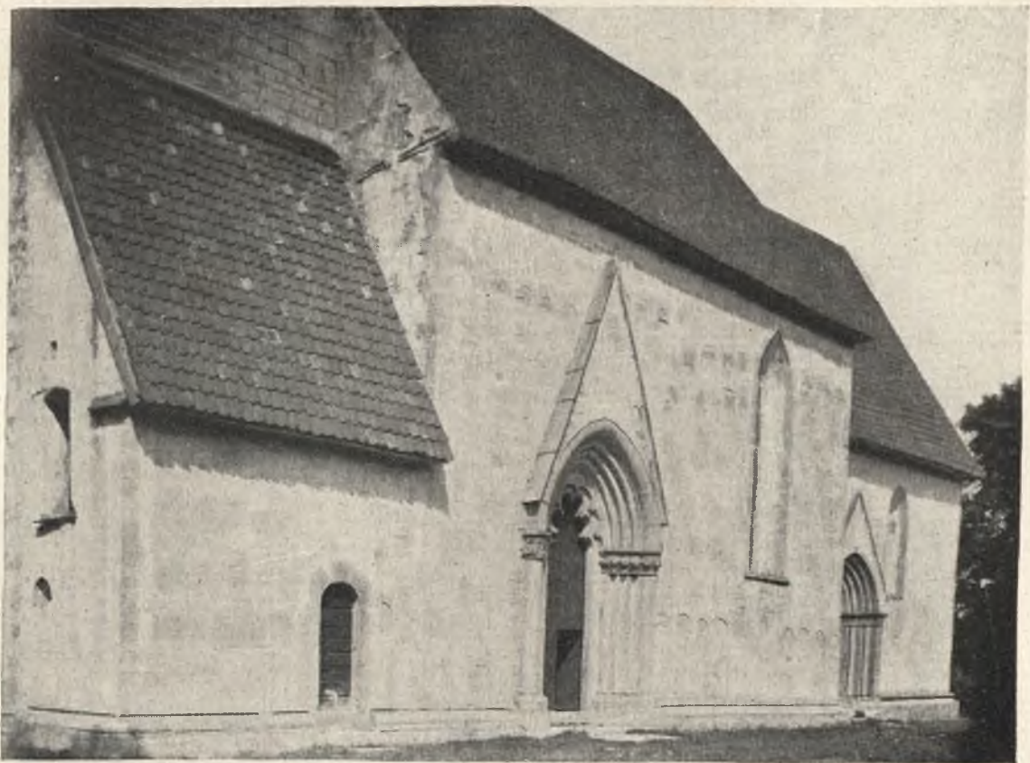
Abb. 15. Kirche Bro, Gotland, Südfassade
